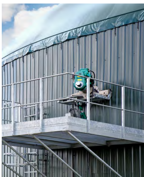
FT - Cuve en béton
