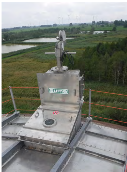
GDD - Cuve en acier
