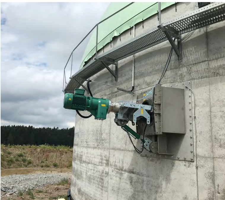
AMX - Cuve fermée
