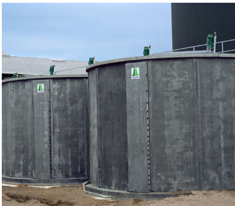
BG2 - Cuve avec plafond en béton
