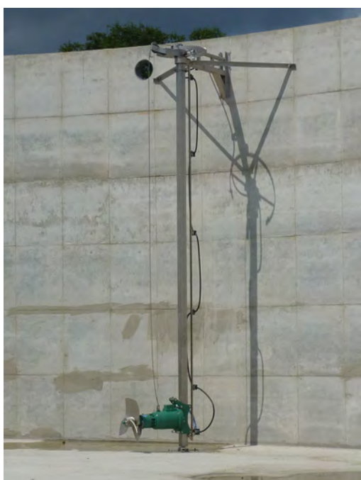
MGD - Cuve en béton avec 2G
