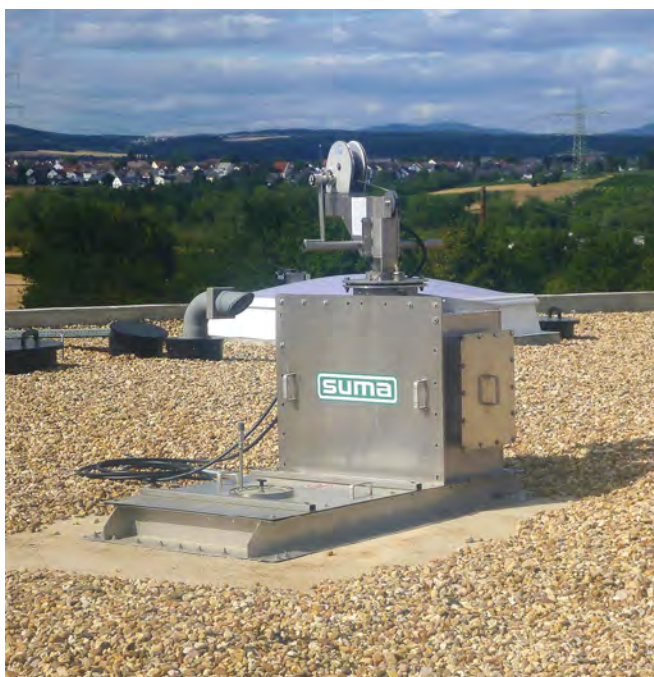
GDD - Cuve en béton
